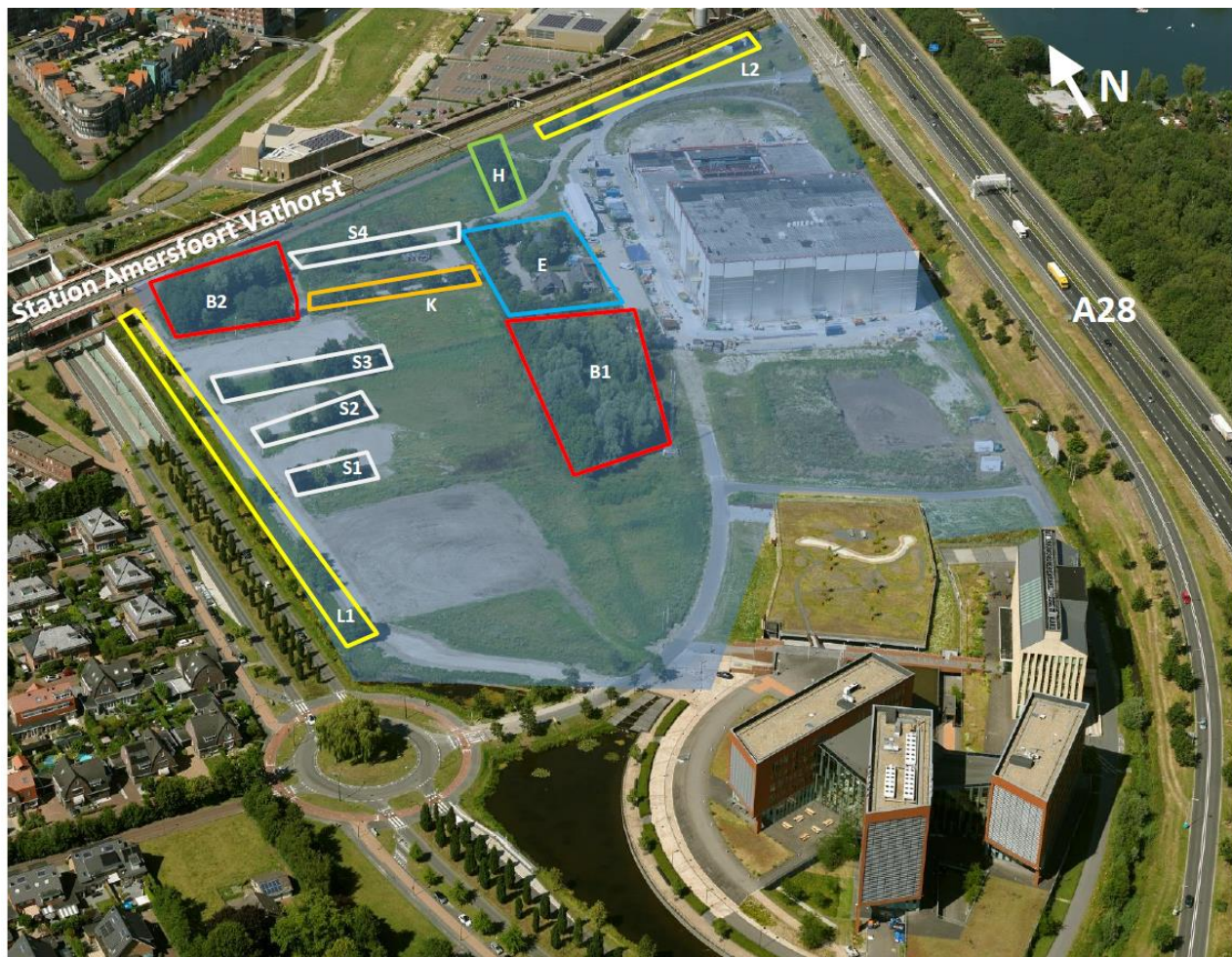
Overzichtsfoto met het projectgebied (blauw gearceerd) tussen de A28, de spoorlijn Amersfoort-Zwolle en de Boerderijenboulevard. Aan de zuidzijde staan al enkele grote bedrijfsgebouwen die in een eerdere fase gerealiseerd zijn. De bomen staan in twee bosachtige houtopstanden (B1 en B2), rond het erf van de oude boerderij (E), of in (restanten van) houtsingels met wisselende samenstelling (S1 t/m S4, H, K). Langs de westelijke en de noordelijke rand staan losse boomstructuren van voornamelijk beuk (L1 en L2).
