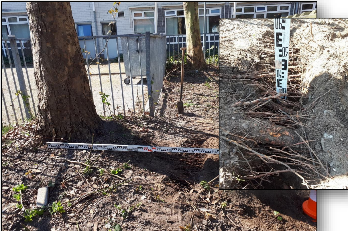
Foto 23: proefsleuf noordzijde boom 11 Inzet: zijaanzicht proefsleuf
