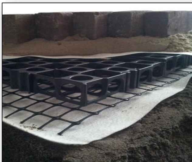
Foto 28: sandwichconstructie (Bron: Greenmax)
