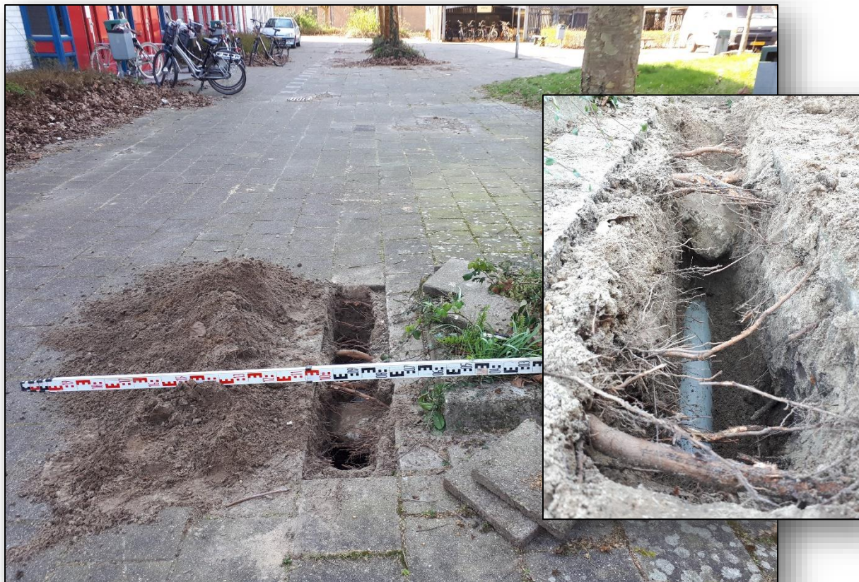
Foto 24: proefsleuf zuidzijde boom 13 Inzet: zijaanzicht proefsleuf
