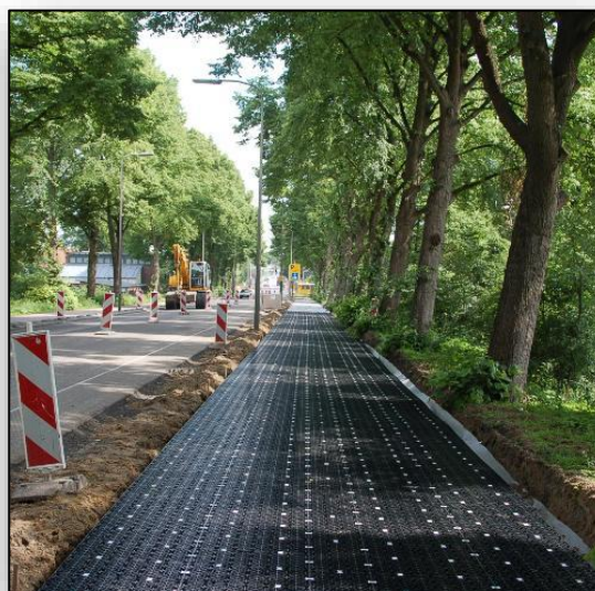
Foto 29: sandwichconstructie onder fietspad (Bron: TGS)
