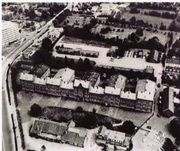
Overzicht vanuit het westen. Links de rondweg. Voor het hoofdgebouw de kantine (links) en het bureel (rechts). Rechts de brug over de Flierbeek.
