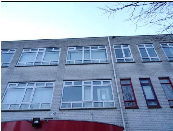
Figuur 9. Plat dak van het schoolgebouw.
