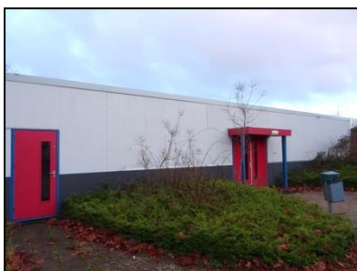
Figuur 6. Noodlokaal aan de noordzijde van het schoolplein.
