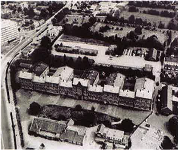
Overzicht vanuit het westen. Links de rondweg. Voor het hoofdgebouw de kantine (links) en het bureel (rechts). Rechts de brug over de Flierbeek.
