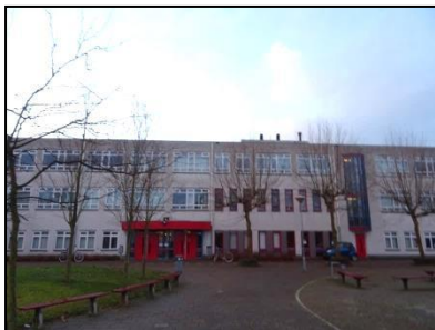
Figuur 3. Noordzijde van de school.
