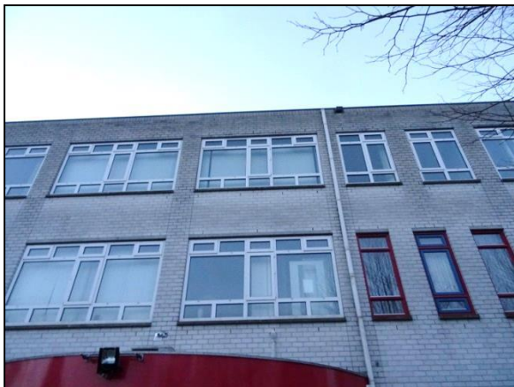
Figuur 9. Plat dak van het schoolgebouw.
