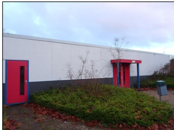
Figuur 10. Platdak van het voormalige noodgebouw.
