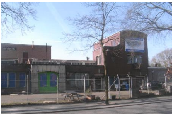
Foto 6: Aanzicht voorgevel westzijde
