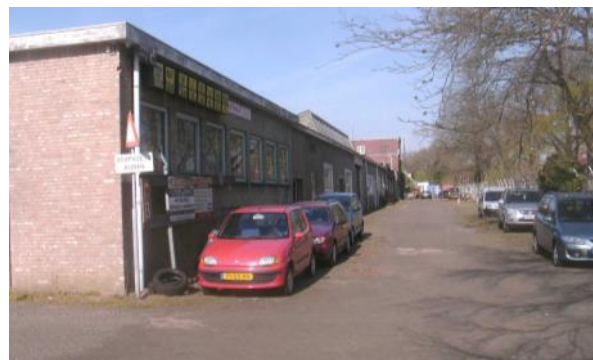
Foto 3: Aanzicht vanaf toegang terrein in westelijke richting (langs de voorgevel)
