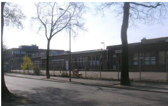
Foto 4: Aanzicht voorgevel oostzijde
