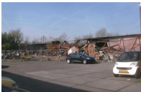
Foto 9: Gedeelte bijgebouw door brand verwoest
