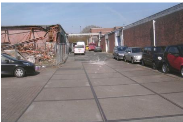
Foto 10: Ruimte tussen hoofdgebouw (rechts op foto) en bijgebouw
