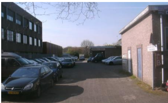
Foto 2: Aanzicht vanaf toegang terrein in zuidelijke richting
