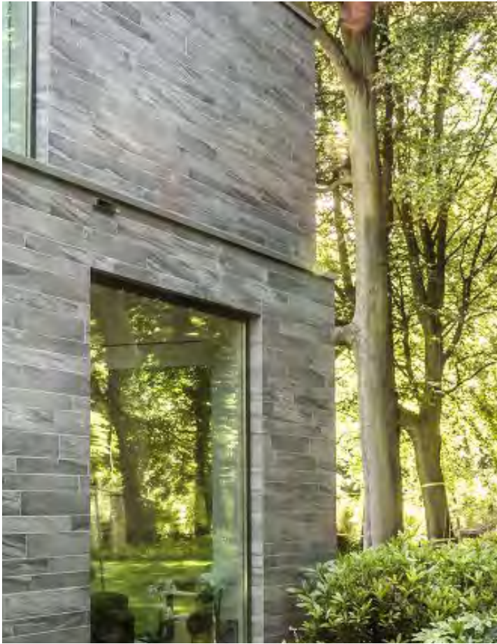
Keramische gevelbekleding, verwerkt op een wijze die een homogeen, abstract gevelbeeld mogelijk maakt en aansluiting vindt met het gebruik van natuursteen elders.
