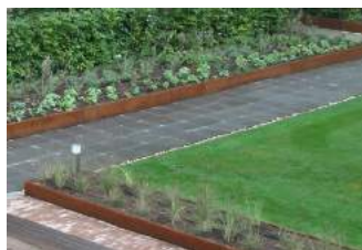
Cortenstalen strip tussen verharding en plantvak op de daktuin
