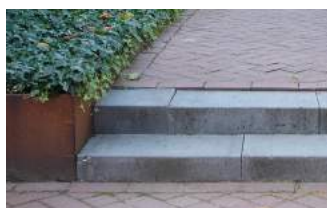
Cortenstalen strip tussen verharding en plantvak op de daktuin
