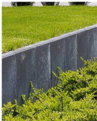
Cortenstalen strip tussen verharding en plantvak op de daktuin
