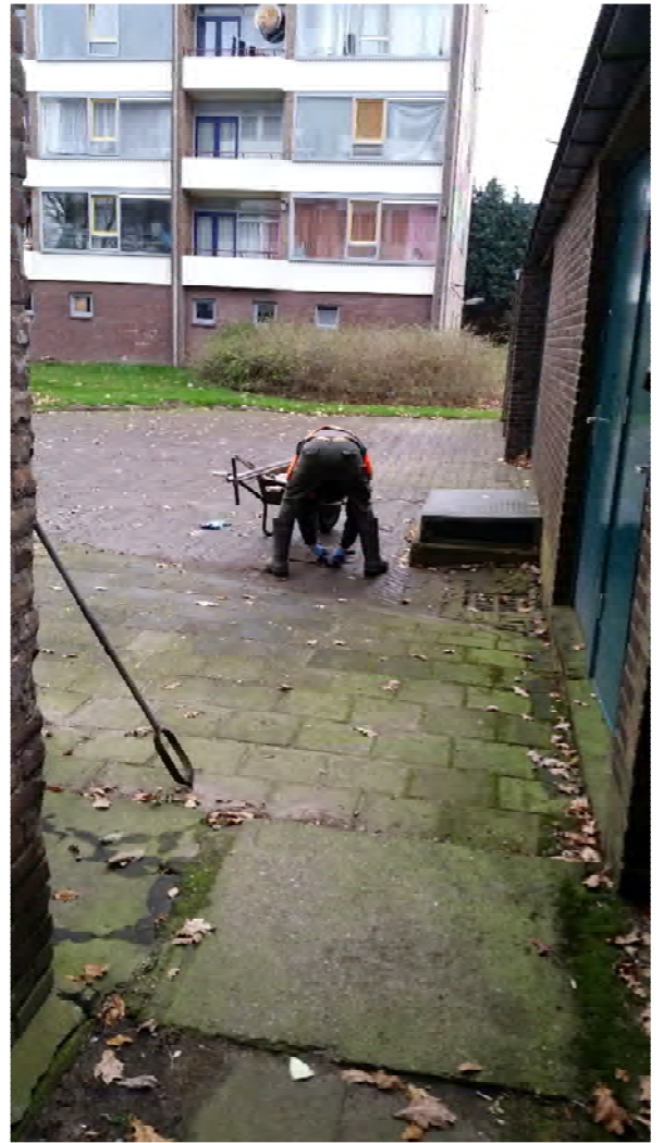
het vulpunt van de voormalige tanks
