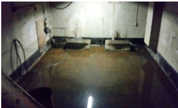
de kelder van de voormalige tanks
