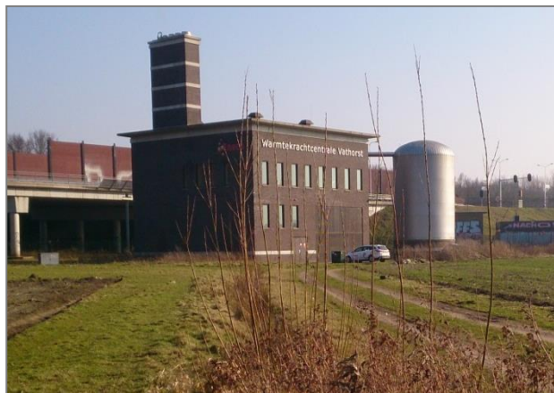
Warmtekrachtcentrale Vathorst in het plangebied.
