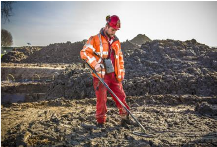
Afbeelding 4: Uitvoeren actieve analoge oppervlakedetectie m.b.v. Vallon VMM/ VMH3CS non ferrous locator maximale detectiediepte van verschillende CE artikelen.
