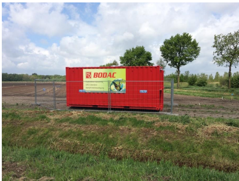
Afbeelding. 20 ft. container waarin de VTVS is geplaatst gesitueerd in het veld.
