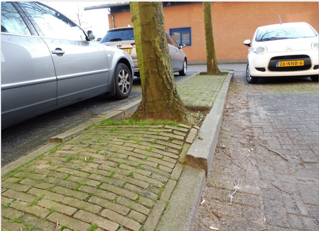
Foto 5: opdruk verharding rond boom 7245
