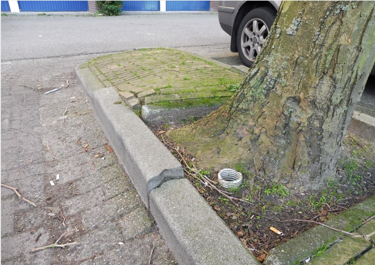
Foto 6: opdruk verharding rond boom 7246
