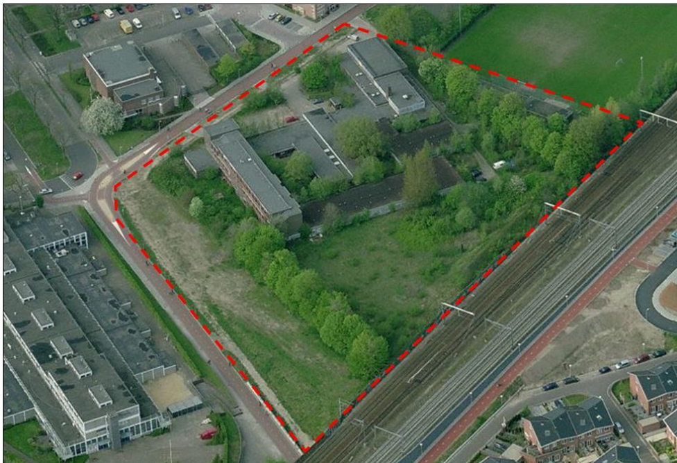
Figuur 2 Huidige bebouwing binnen het projectgebied
