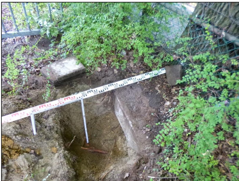
Figuur 11 Proefsleuf bij boom 158 op de locatie van de aan te leggen Wadi
