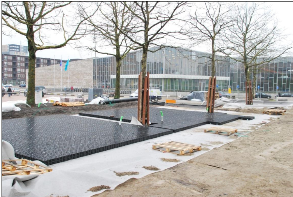
Aanleg van een parkeerplaats boven het wortelstelsel van platanen met een onderconstructie van holle kunststof platen in Amsterdam Zuidoost.
