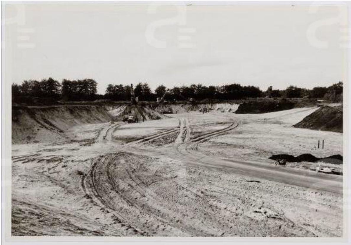
afbeelding 10, veel grondverzet bij de aanleg van de Stichtse rotonde. Bron: Archief Eemland.
