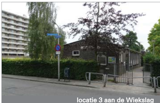
locatie 3 aan de Wiekslag
