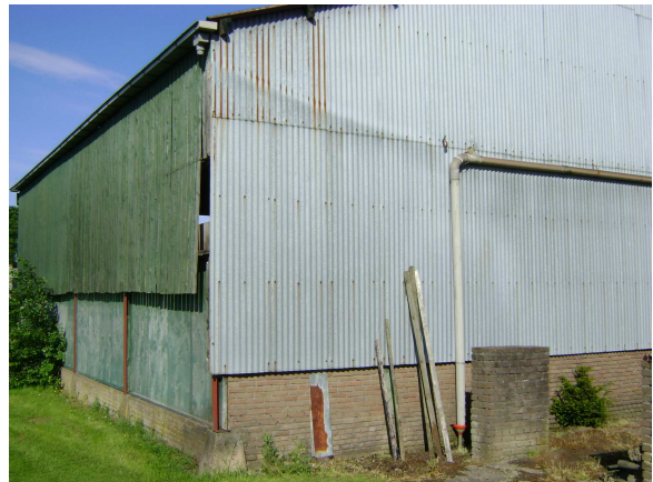
Foto buitenzijde achterste gebouw
