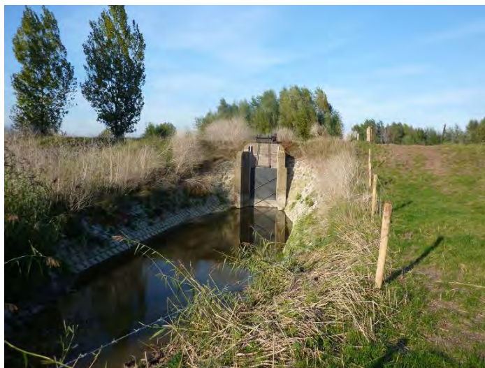
De sluis in de zomerkade waardoor het water bij opkomend water wordt ingelaten en na een overstroming weer wordt uitgelaten.
