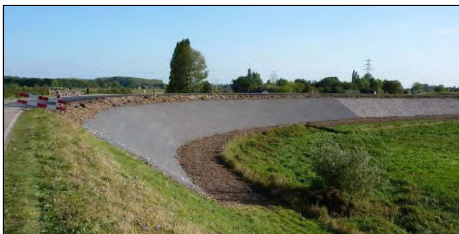
Figuur 3.49 De dijk is recent van een nieuwe bekleding voorzien [Stroming, 2010]
