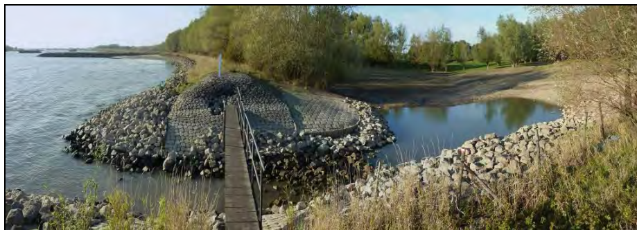
Figuur 3.30 De ingang van de geul van Opijnen [Stroming, 2010]
