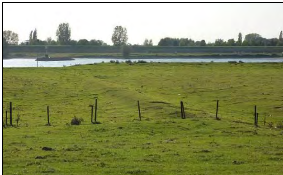
Figuur 3.55 Ingegraven kribben door sedimentatie [Stroming, 2010]
