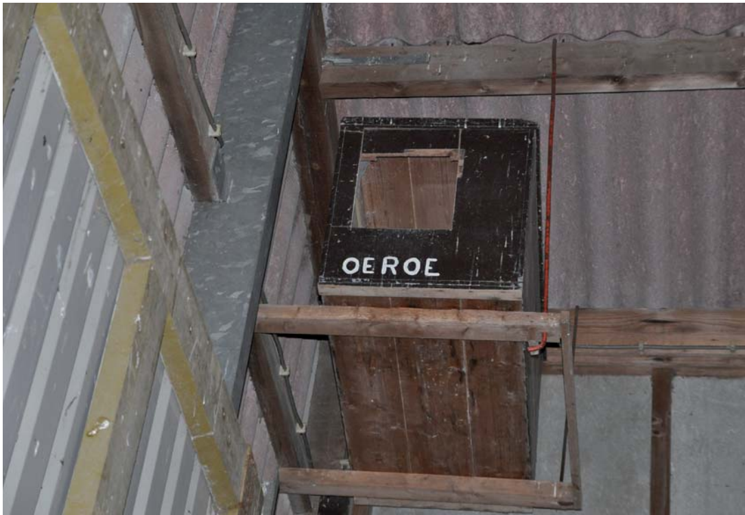
Kerkuilenkast in de schuur direct achter de woning.
