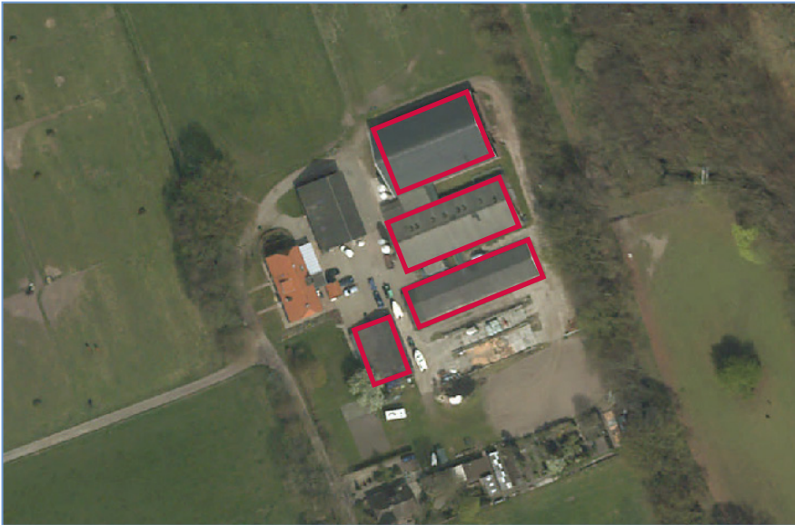
Luchtfoto bestaande situatie. Rood omlijnde bebouwing wordt gesloopt.
