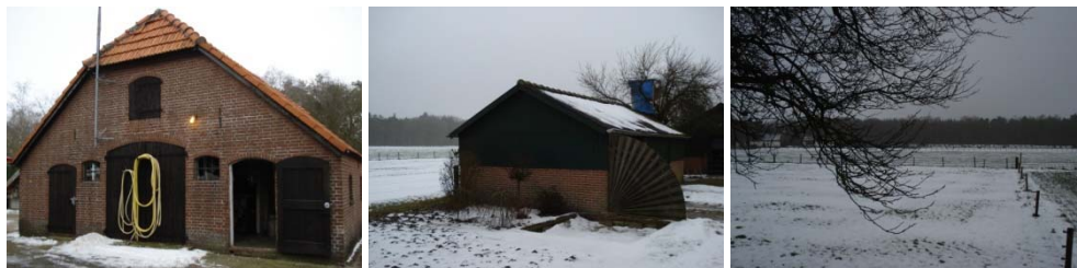
Foto's: Te slopen opstallen 4 en 5 en de directe omgeving.
