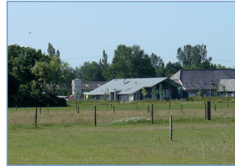
Rechthoekige vorm, zadeldak met lage goten. Een voormalige varkensschuur omgebouwd tot woning.
