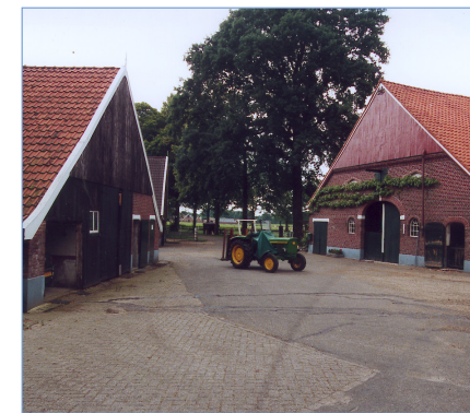
De gebouwen zijn toegankelijk vanaf het open erf. Ook wanneer de schuren worden vervangen voor woningen.
