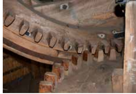
22, 23. Anatomie van de Bolwerkmolen van boven naar beneden. Links molenaar Rob Schutte in de kap, waar de ijzeren as met het bovenwiel loopt die door het wiekenkruis in beweging wordt gezet. Rechts: het verticaal geplaatste bovenwiel zet via de bovenbonkelaar (horizontaal tandwiel) de koningsspil in beweging.
