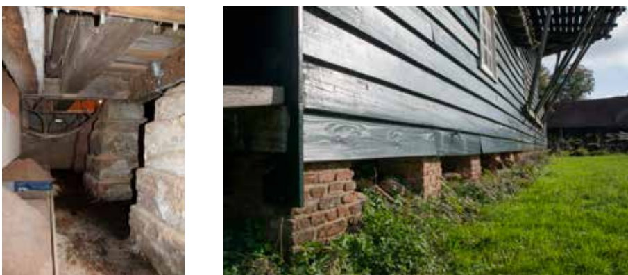
32-35. De molen staat op teerlingen (poeren). Hiertussen wordt in het kot ook het zaagsel opgevangen. Het zaagraam en het krabbelrad vallen door een spleet in de vloer (linkerfoto's).
