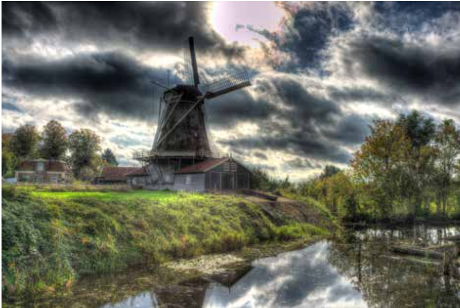
20. De Bolwerksmolen in Deventer, een achtkante zaagmolen. Rechts zijn de sleephelling en het balkengat te zien.
