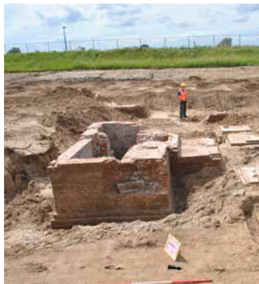
114-115. Blick in de sleuf voor het vliegwiel van de stoommachine. Rechts het blok gefotografeerd richting westen. De hoek is beschadigd omdat hij in 1950 is bijgekapt om er een septic tank te plaatsen.
