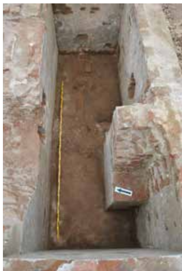
114-115. Blick in de sleuf voor het vliegwiel van de stoommachine. Rechts het blok gefotografeerd richting westen. De hoek is beschadigd omdat hij in 1950 is bijgekapt om er een septic tank te plaatsen.
