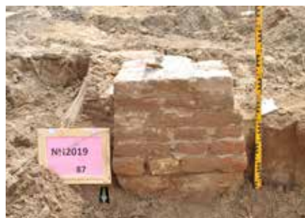
109-110. Links de bovenkant van een van de oorspronkelijke teerlingen. Rechts een secundair aangebracht exemplaar. In de constructie zijn daar vier van aanwezig. Aan de onderzijde zijn ze opgebouwd uit middeleeuwse bakstenen.
