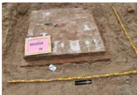
109-110. Links de bovenkant van een van de oorspronkelijke teerlingen. Rechts een secundair aangebracht exemplaar. In de constructie zijn daar vier van aanwezig. Aan de onderzijde zijn ze opgebouwd uit middeleeuwse bakstenen.
