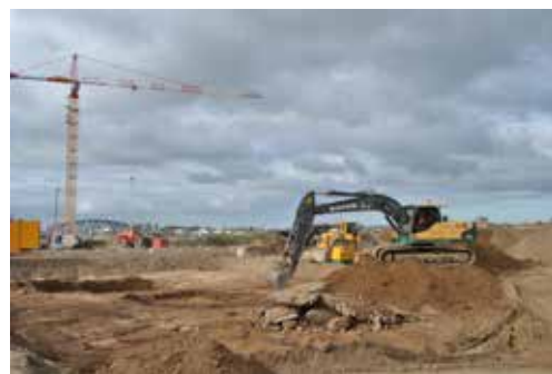
3, 4. Links het machinaal uitzeven van de grond en rechts een overzicht van het terrein met bouwkranen, shovels en een graafmachine waarmee een archeologisch vlak wordt aangelegd.
