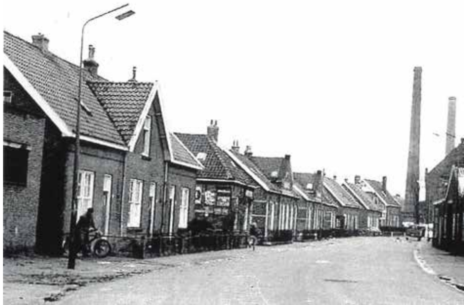
154. De Voormars inclusief de woningen uit 1925. Gezien vanaf de Bolwerkweg, met op de achtergrond de schoorstenen van de gasfabriek.
