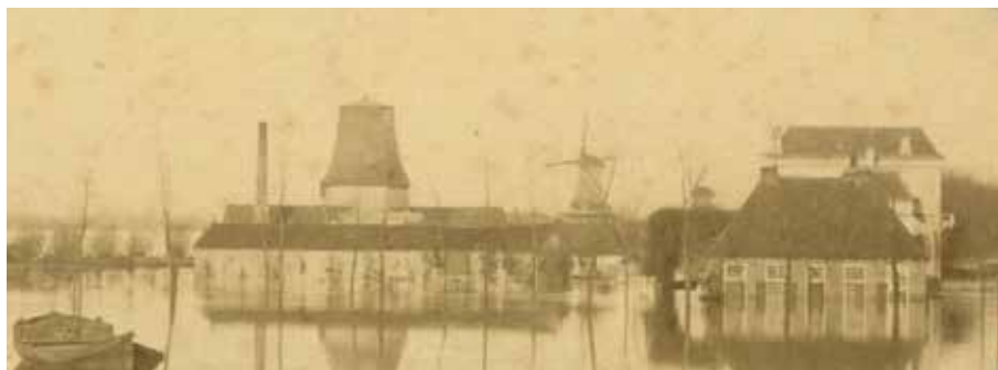
142. Detail uit de hoogwaterfoto uit 1883. We zien hier de noordelijke zaagmolen met schoorsteen en zonder wieken. Op de achtergrond de twee molens van de papierfabriek van Hissink. Rechts zien we twee gebouwen. Het gebouw vooraan was mogelijk een gedeelde dienstwoning voor de belangrijkste werknemers, het gebouw op de achtergrond is waarschijnlijk de villa van directeur Wijers. Uit de opgraving blijkt dat tussen de gebouwen in nog een houten schuur stond.
