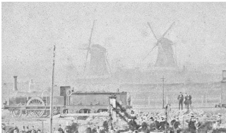
59. Op de bekende foto van de opening van het station in Zutphen in 1863 zijn waarschijnlijk de twee windmolens van de zagerij te zien. Eerder zijn ze geïnterpreteerd als de twee molens van het oliemolencomplex.
