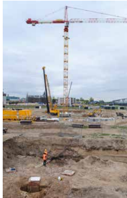
2. Het uitgraven van de zuidelijke molen onder de bouwkraan en de heimachine.
