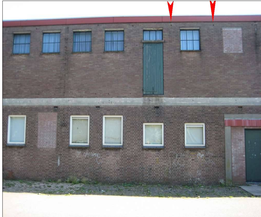
Pand aan de Bolwerksweg met verblijfplaats Gewone dwergvleermuizen en twee belangrijke in-/uitvliegopeningen.
