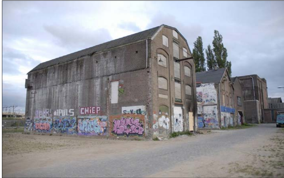
Vervallen panden aan de Noorderhaven.
