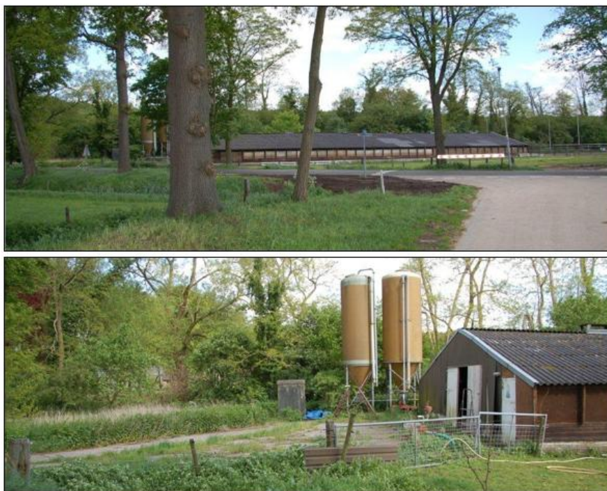
Figuur 2.3 Aanzichten van het zuidelijk plangebied (Bron: Google Streetview)
