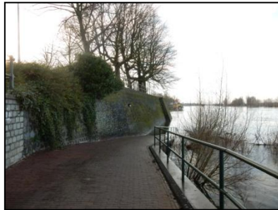
Figuur 10. Kade op zuidelijke deel van de onderzoekslocatie.
