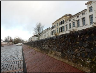
Figuur 9. Kade met basaltstenen.
