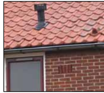
gaten in de buitenmuur
