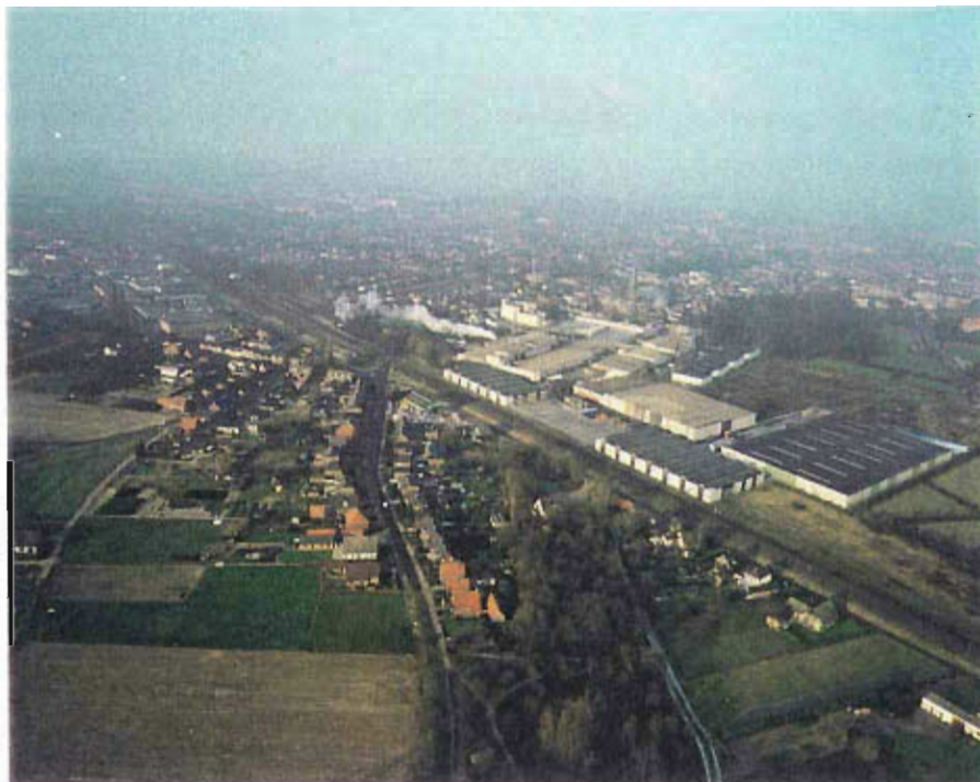
Figuur 2.1.3 Zevenaar vanuit de lucht. De blik is west-noordwest. Beneden loopt de Oud Zevenaarseweg. De Betuweroute en de HSL-Oost worden gebundeld met de bestaande spoorlijn Arnhem-Emmerich.
