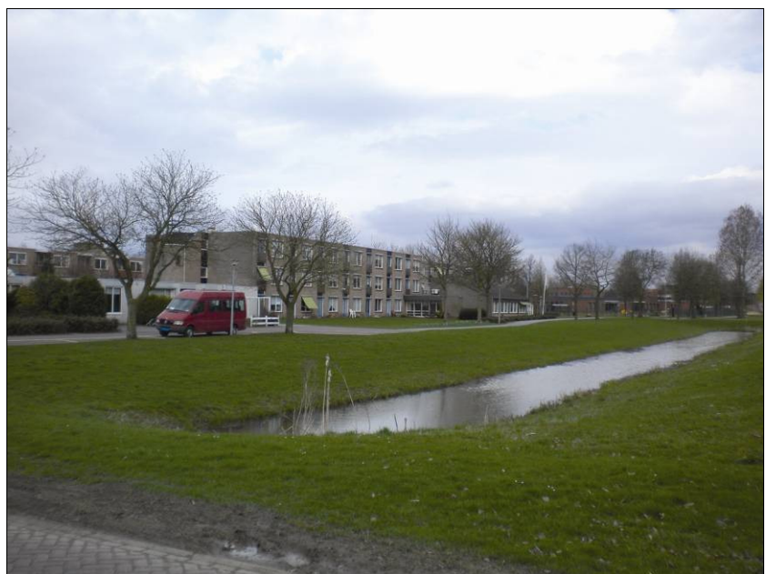
Figuur 1: Ligging van het te slopen gebouw langs de Platanenlaan.
