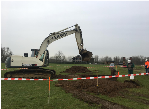
Figuur 3.1 Inzet hydraulische graafmachine
