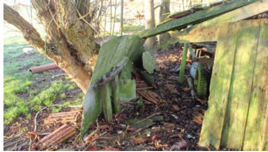
Afbeelding 13: asbest verdachtmateriaal-4
