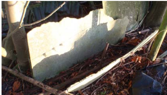
Afbeelding 10: asbest verdachtmateriaal-1
