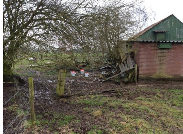
Figuur 8: Overzichtsfoto bebouwing
