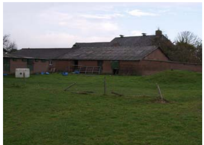
Te slopen varkensschuur
