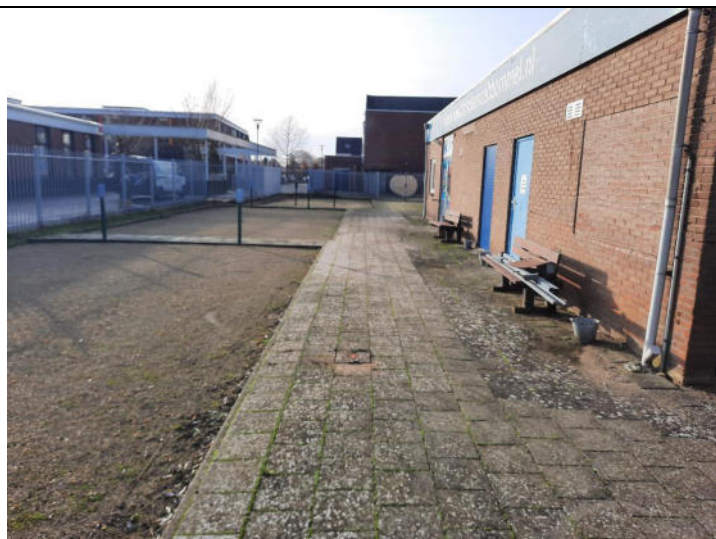
Foto 4: Achterzijde zwembad richting het zuidwesten
