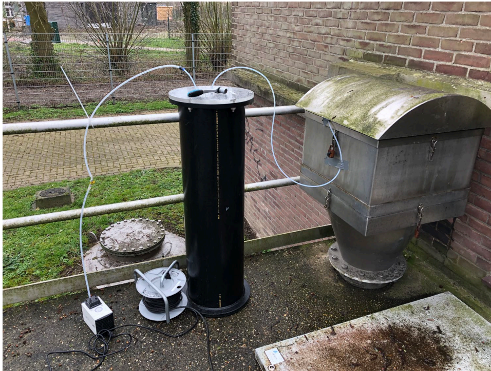
Foto B5.3. Geurmetingen aan aflaat met filter.
