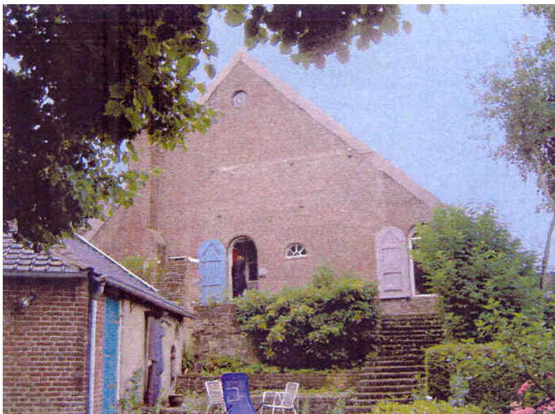
Voor- en achtergevel
