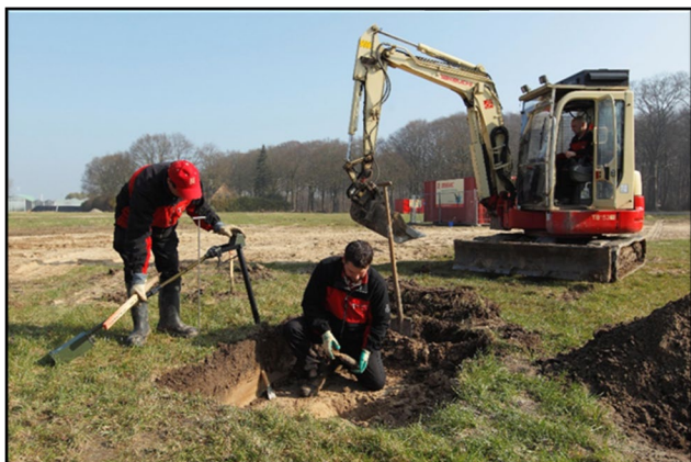
Figuur 4. Benaderen van een significant object m.b.v. een hydraulische graafmachine.
