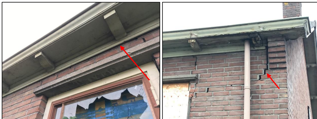
Geschikte openingen voor gebouwbewonende vleermuizen in de bebouwing
