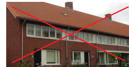
Dominante horizontale gevelgeleding
