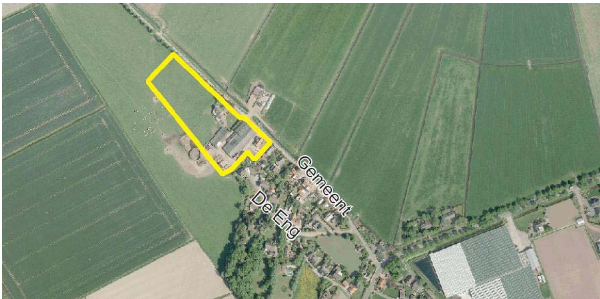
Figuur 8: plangebied met voormalige agrarische bebouwing
