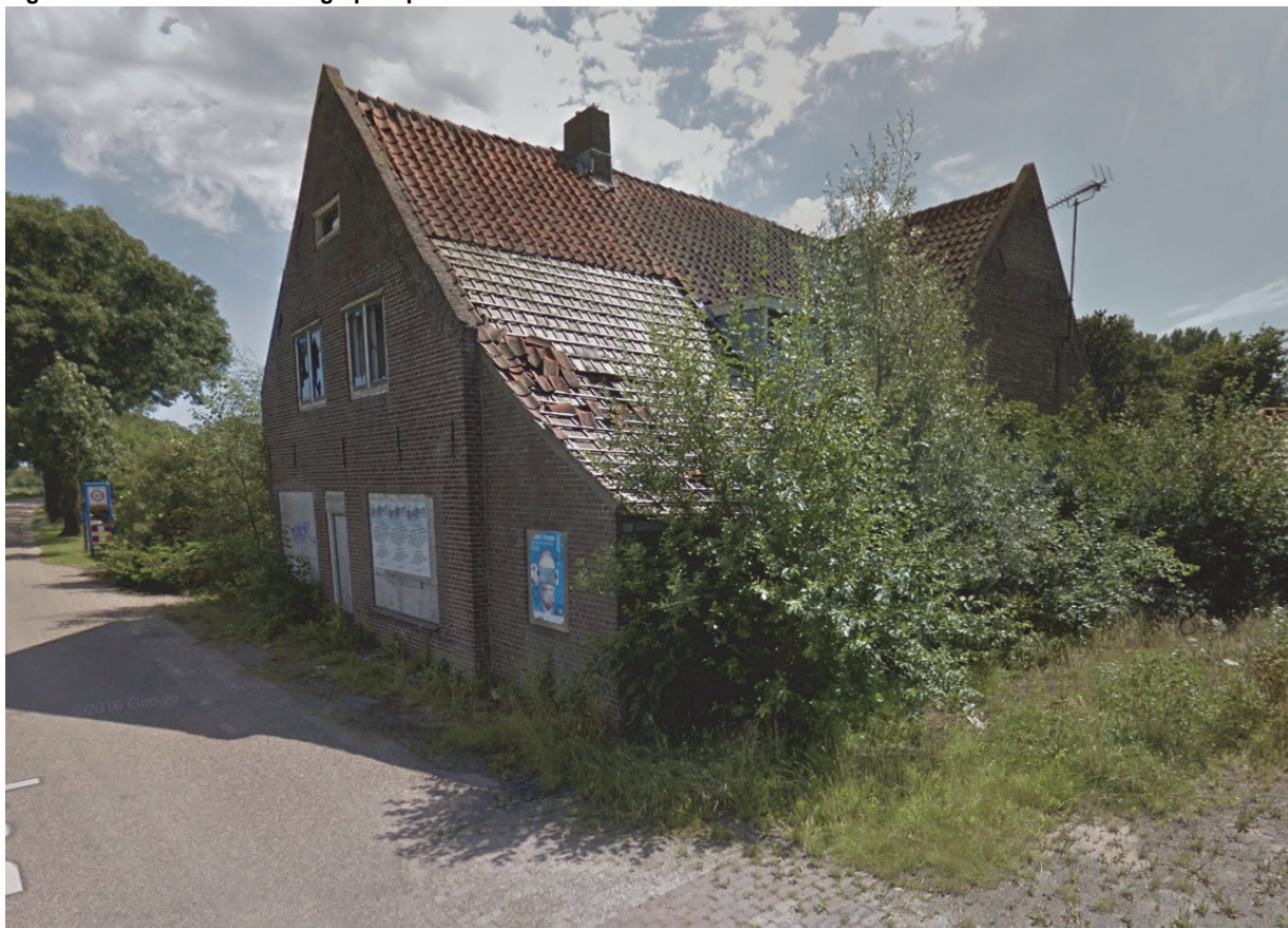
Figuur 1: Vervallen bebouwing op de planlocatie 2
