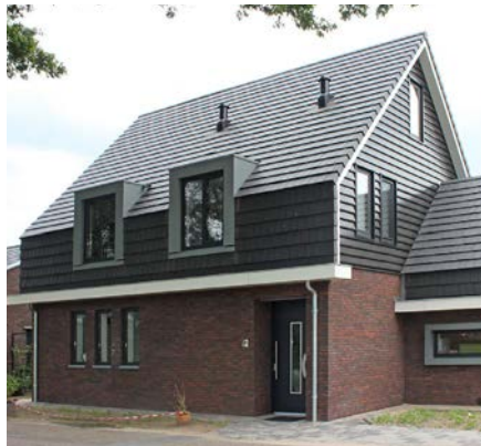
Fig. 4.3 Toepassing mansardekap
