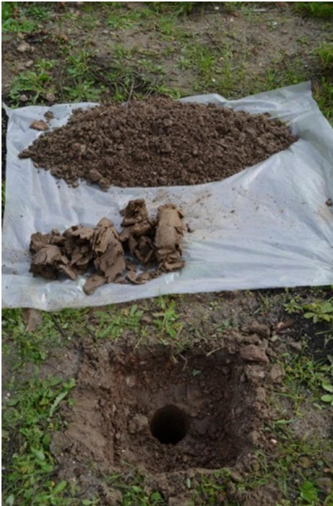
Foto 3: Inspectiegat asbest (IG13) met opgegraven menggranulaat (boven) en opgeboorde (schone) kleigrond
