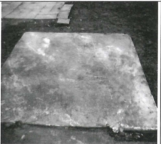
toelichting foto 4: plaats waar de koelcel gestaan heeft
