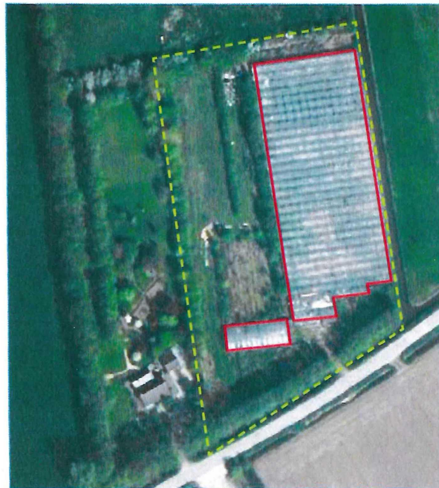
Luchtfoto met erf aan Krangstraat 2a. De groene stippellijn geeft de erfgrens aan. De rood omlijnde kassen worden gesloopt.
