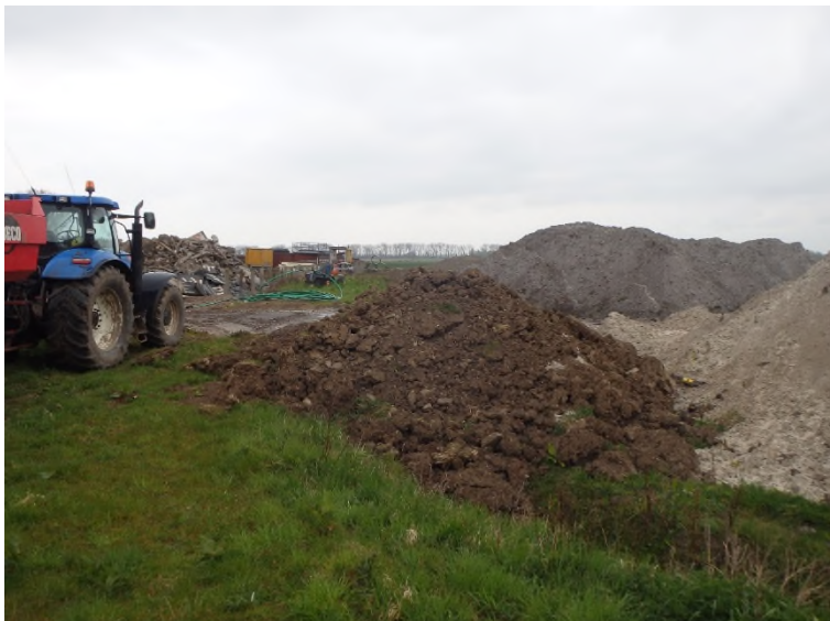
Foto: grond depots (na)bij aannemersbedrijf
