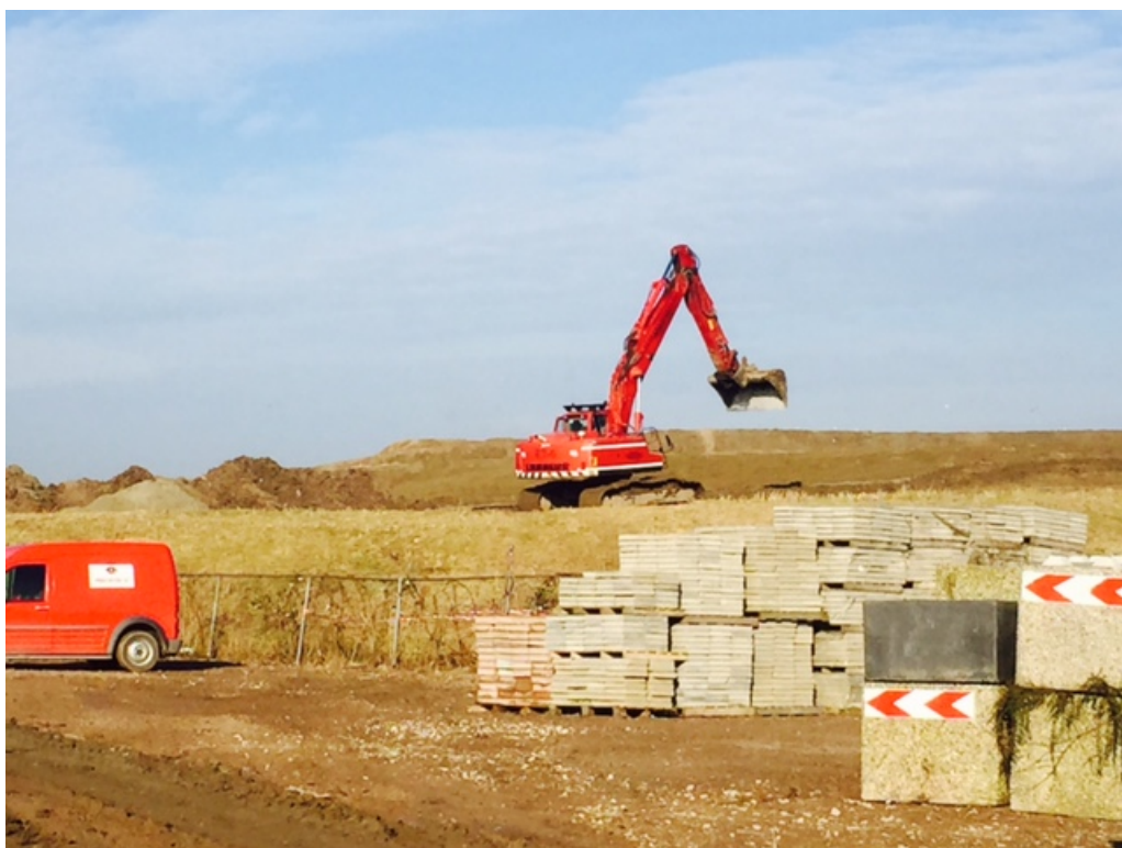
Figuur 2 Op de locatie vindt grondverzet en –transport plaats. Het westelijke deel van de planlocatie is verhard met puin en in gebruik als opslag van (bouw)materialen.
