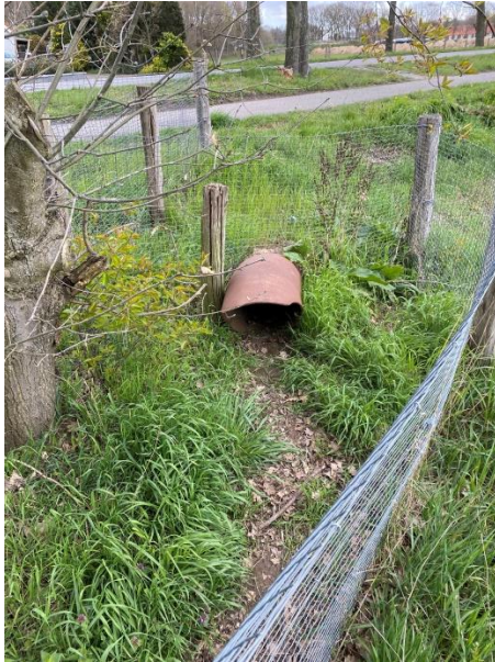
Foto 9: Wissel tunnel Oosterweg
