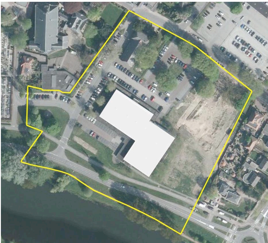
Figuur 2. Luchtfoto recente situatie projectgebied. Het witte gebouw in het centrum van het projectgebied is inmiddels gesloopt.
