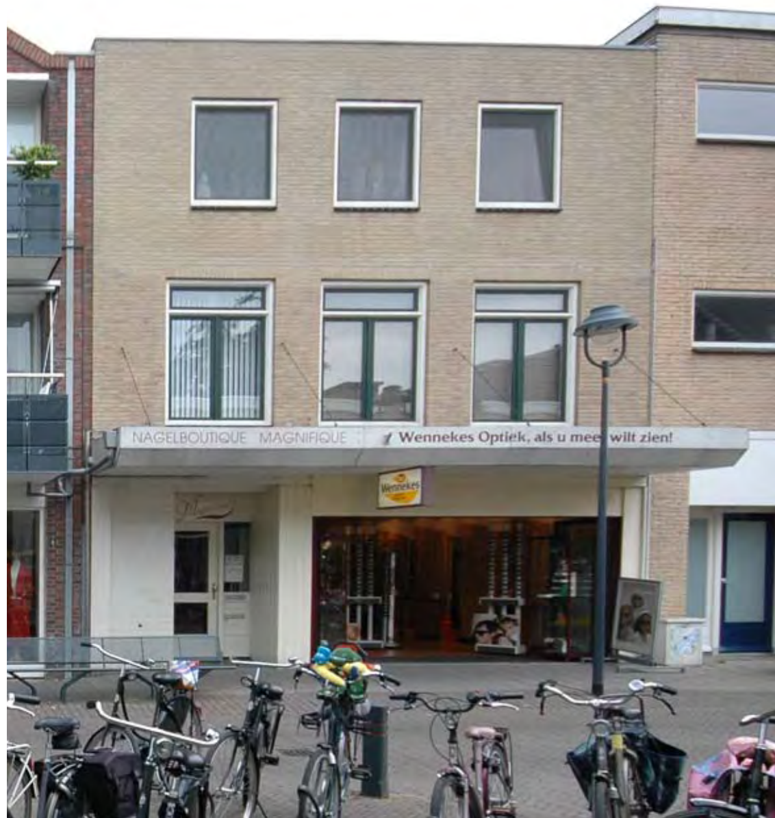
• Pand Wennekes bestaande situatie
